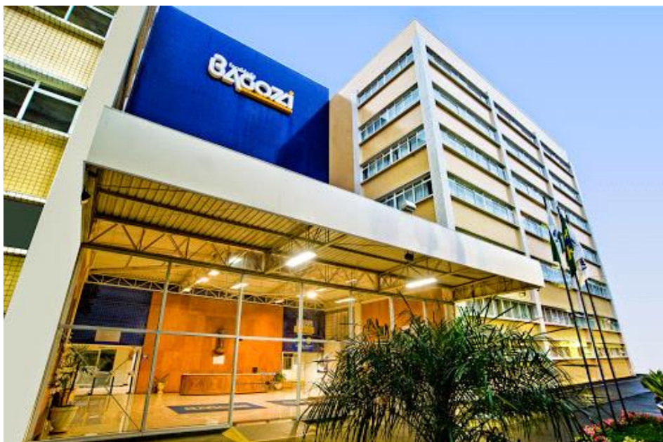
Faculdade Padre João Bagozzi – Bairro Portão – Curitiba-PR. Fonte: interna.
